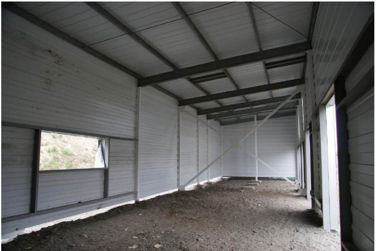
Рисунок 14. Временная площадка накопления ТКО.
